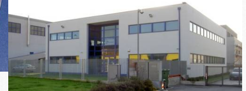
Optoi new plant, Trento
