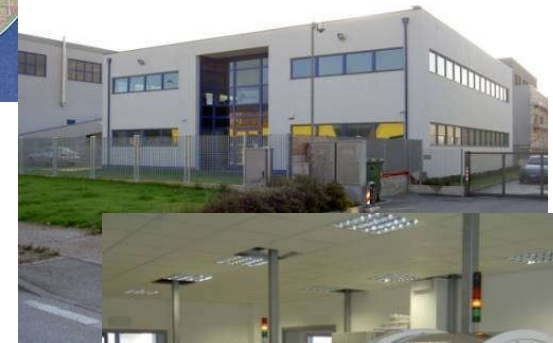
Optoi plant, Trento
